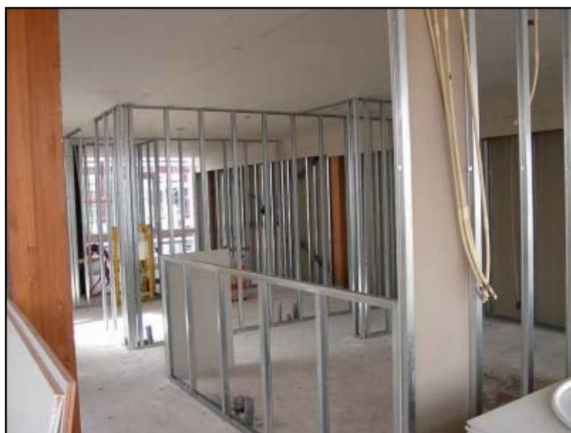
Toepassing C en U-profielen voor wanden
