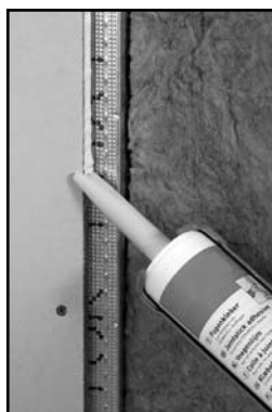
Speciale spuitmond bij lijmvoegmethode
