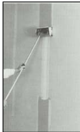
Uitstrijkbak, aanbrengen volgende lagen
