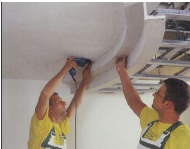
Monteren van een prefabelement (Lafarge)
