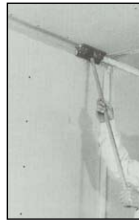
Hoekroller, verwijderen overtollige voegenvuller
