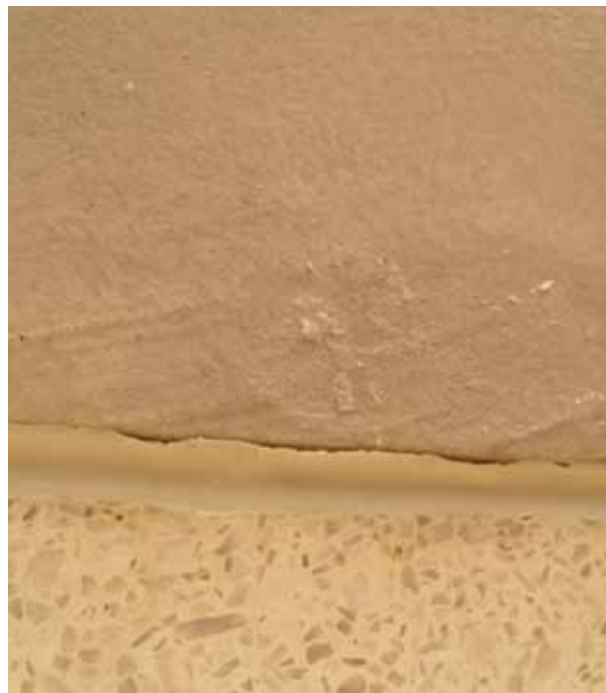
De kitvoeg was niet overal gelijkmatig en strak.
