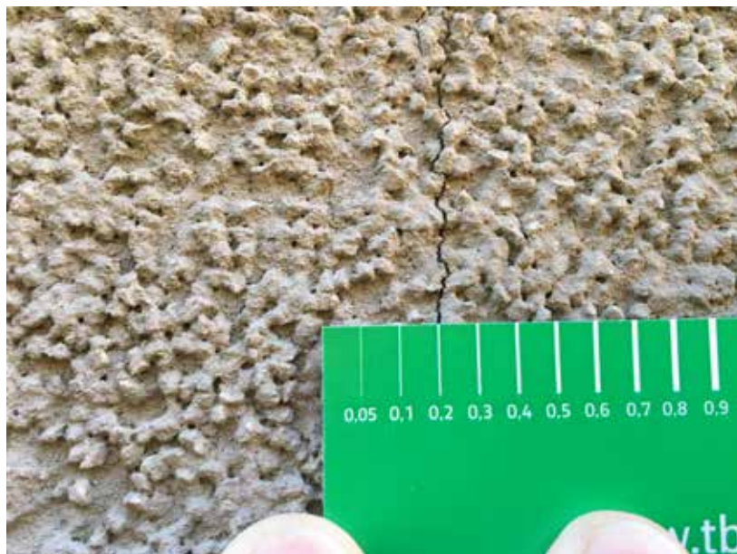
De gemeten scheurwijdte ligt tussen de 0,2 en 0,3 mm.
