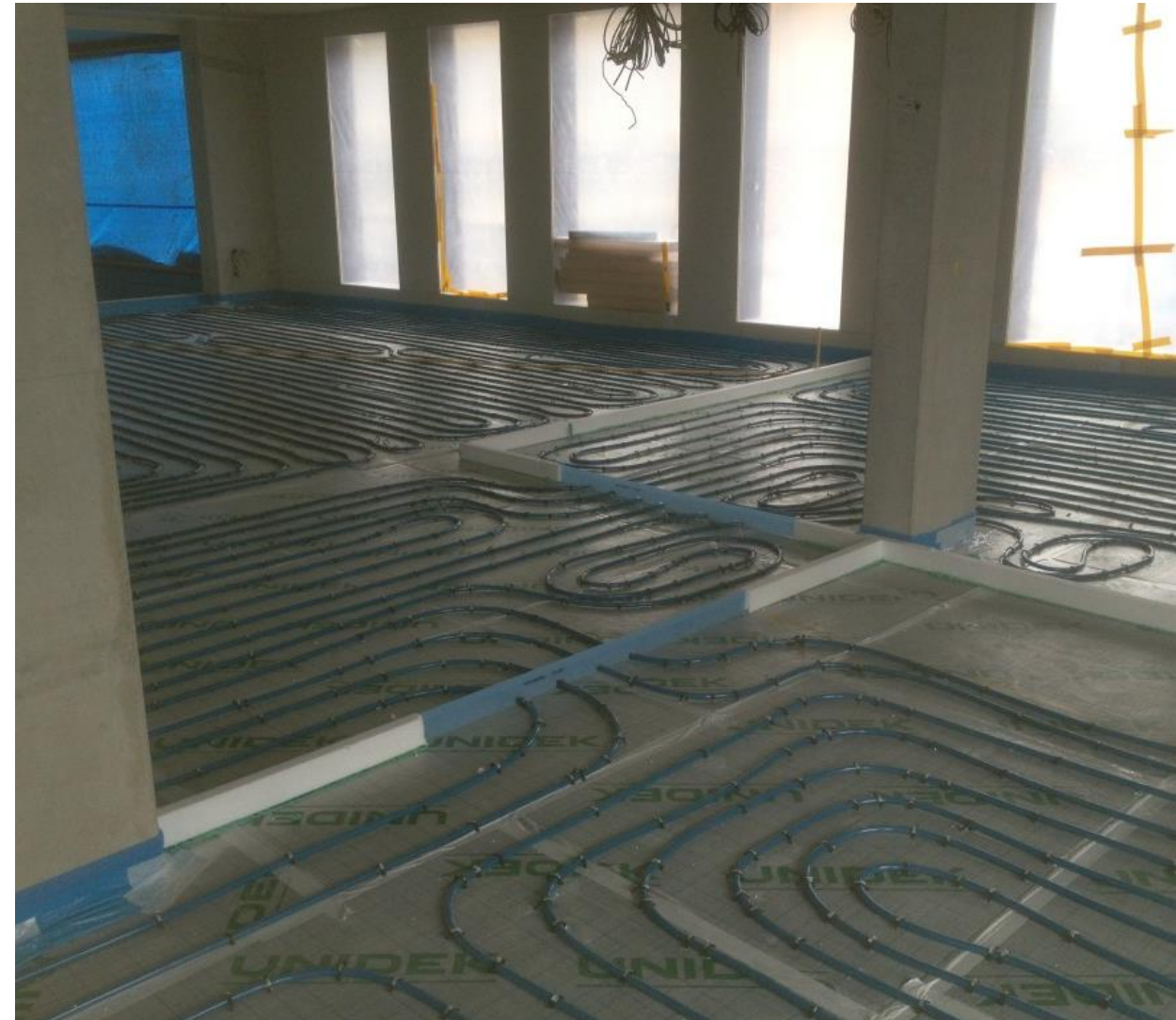
Zwevende vloer van Vloerenbedrijf van Rijbroek BV
