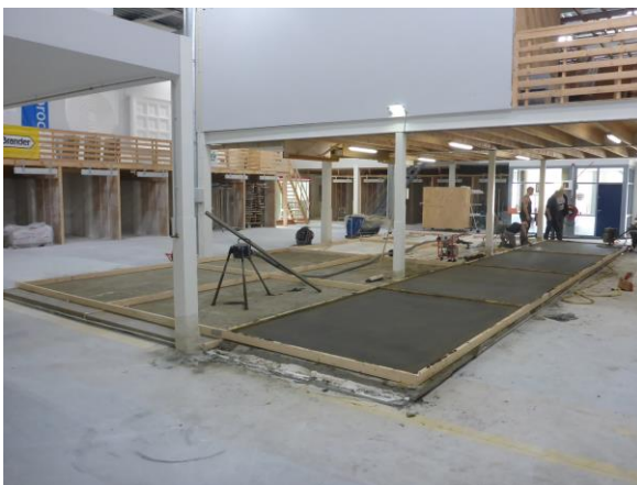
Figuur 21 Proefvloeren fase 2 in uitvoering.
