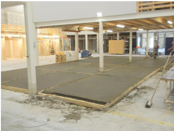
Figuur 11 Proefvloeren gereed.
