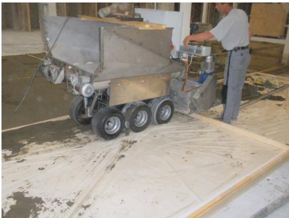
Figuur 9 Proefvloer (zowel hechtend als verend opgelegd) vervaardigd met FloorMach Prototype.
