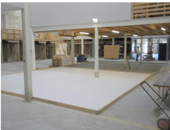
Figuur 3 De helft van het oppervlak is voorzien van een (slappe) isolatielaag ten behoeve van verend opgelegde proefvloeren, de andere helft is bedoeld voor de hechtend aan te brengen proefvloeren.
