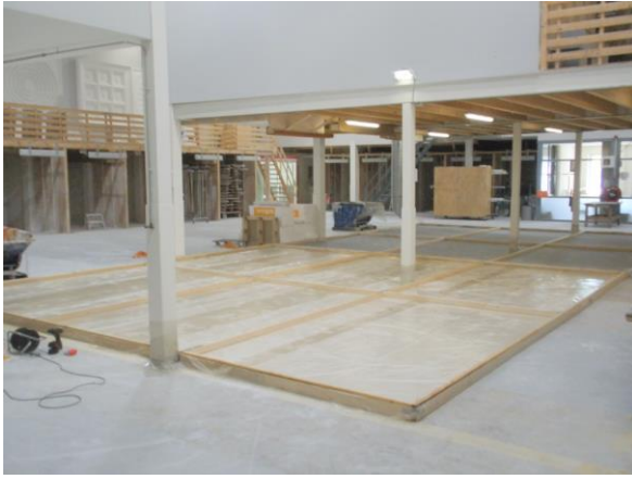
Figuur 4 Op het geïsoleerde vloerdeel is een scheidingsfolie aangebracht.
