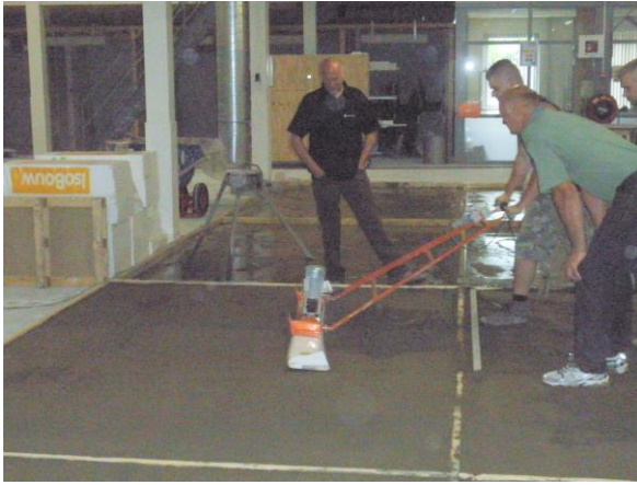
Figuur 7 Proefvloer (zowel hechtend als verend opgelegd) vervaardigd met AirOne NL.
