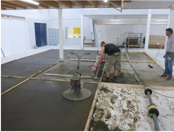
Figuur 22 Na gereedkomen proefvloer werd deze telkens afgewerkt met een vlindermachine om de eventuele laatste onregelmatigheden in het oppervlak te verwijderen.
