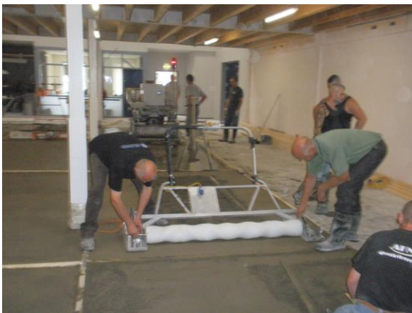
Figuur 6 Proefvloer (zowel hechtend als verend opgelegd) vervaardigd met Screed Roller.
