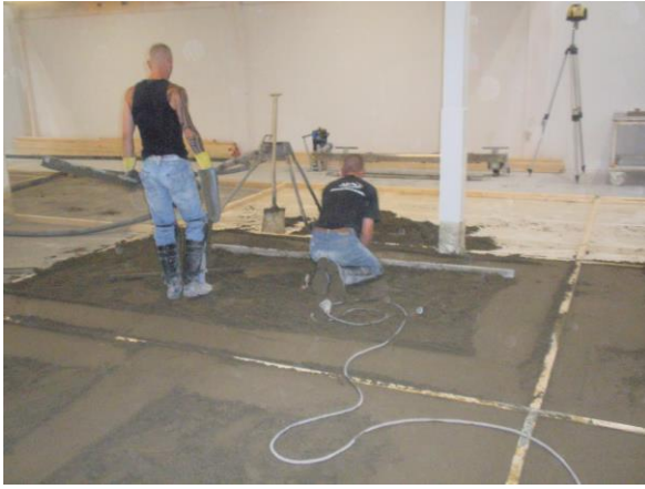
Figuur 10 Proefvloer (zowel hechtend als verend opgelegd) vervaardigd op traditionele wijze.
