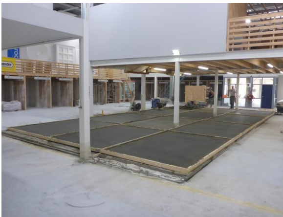
Figuur 23 Proefvloeren fase 2 gereed.
