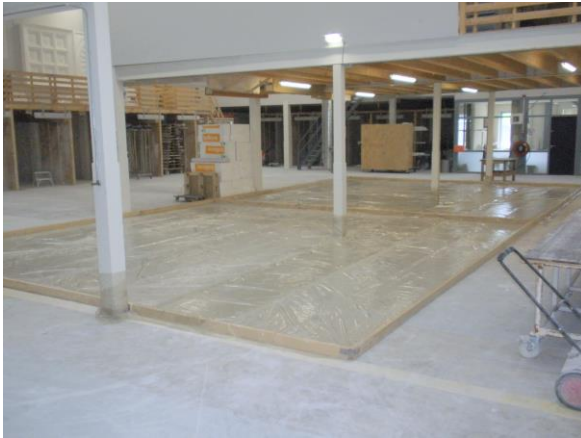
Figuur 1 Bestaande constructievloer is voorzien van scheidingsfolie.
