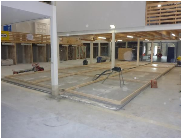
Figuur 20 Op de verende dekvloeren wordt nu een hechtende dekvloer aangebracht, waarbij de eerste dekvloer als constructievloer gaat functioneren. Op de voormalige hechtende proefvloeren is weer een isolatielaag en een scheidingsfolie aangebracht en komen nu de verend opgelegde proefvloeren van fase 2.
