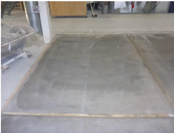
Figuur 14 Aanzicht gerealiseerde dekvloeren na verwijderen folie.
