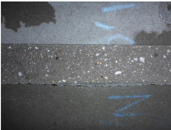
Figuur 29 Verdichting verend opgelegde dekvloer is uitzonderlijk goed en constant, zeker indien daarbij de zeer slappe isolatielaag wordt overwogen.
