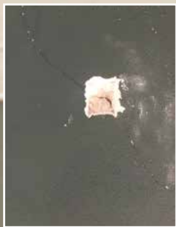
Slaapkamer, aansluiting plafond.
