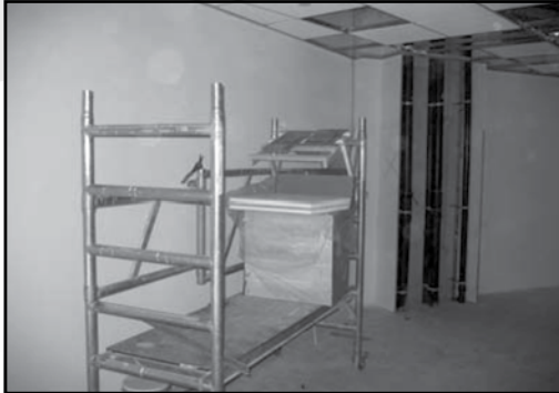
Figuur 7: Kamersteiger uitgerust als werkbank voor het passnijden van vulelementen
