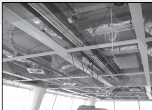
Figuur 4: (Veel) techniek tussen onderkant constructievloer en bovenkant systeemplafond
