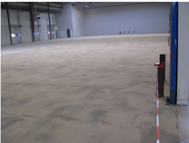
Figuur 5.4: Onregelmatige dekking met als resultaat vlekkerig beeld
